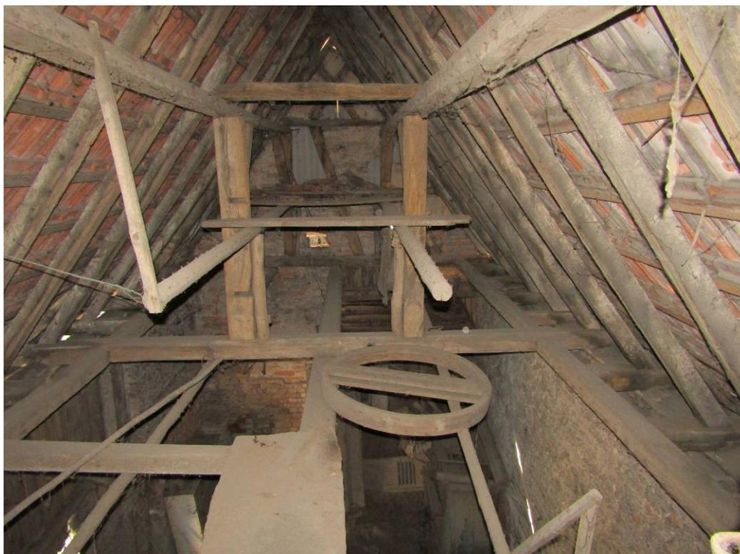
**Foto 9:** Nordanbau des Häuschens mit Stangen zur Tabaktrocknung; Blick nach S
